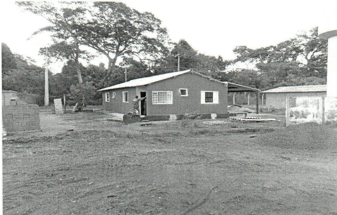
Foto nº 1 - Reforma da casa do caseiro
