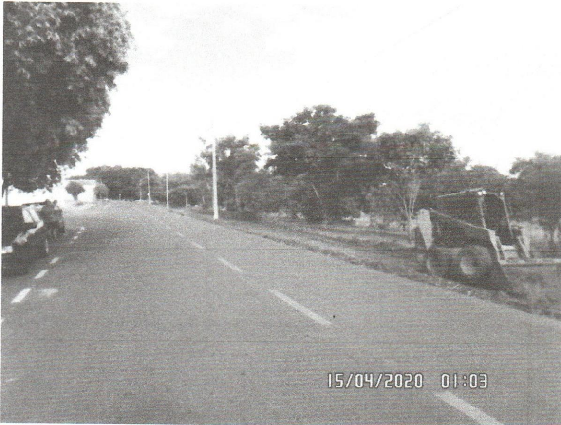
Limpeza do solo no canteiro Central da Avenida Mangara entre a Rua Filomena Tofaneli Bomfim e Avenida Parana
