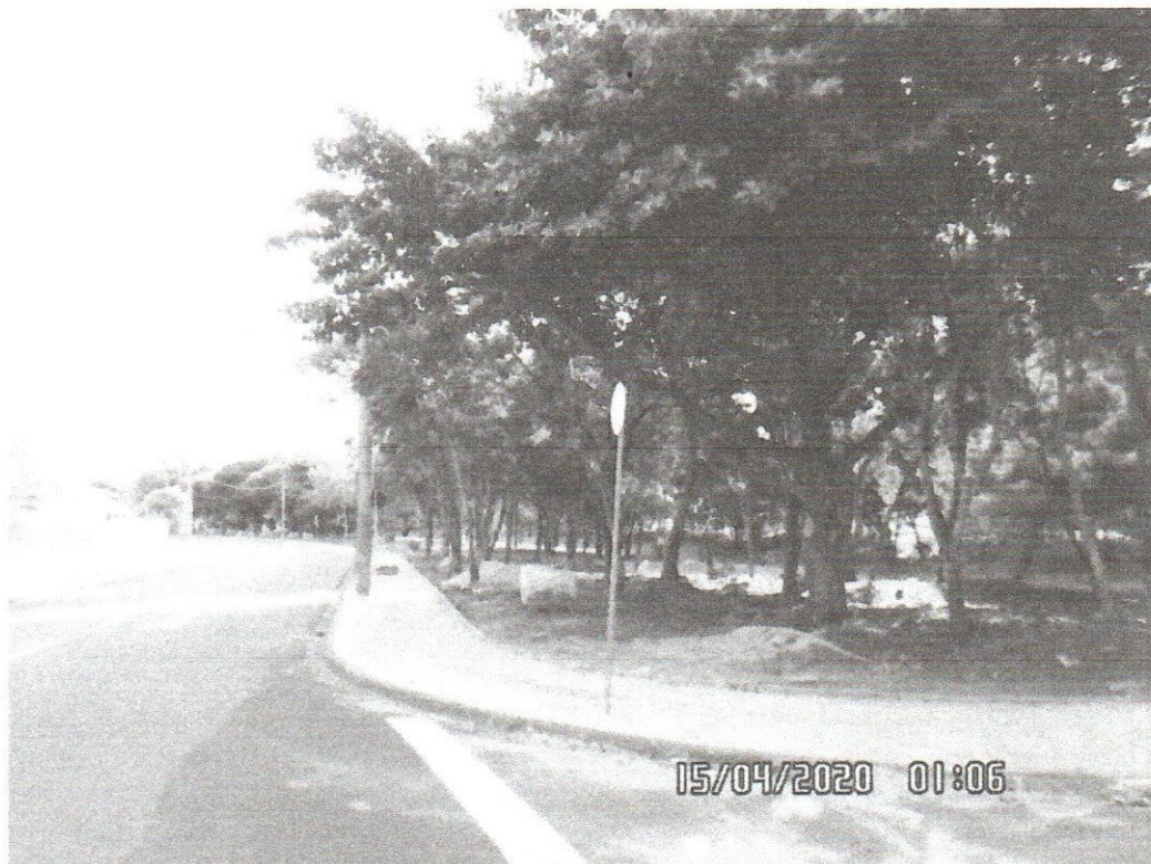
Execução de Pavimentação em lajota de concreto no canteiro central da Avenida Mangara esquina com Rua Pedro Curti
