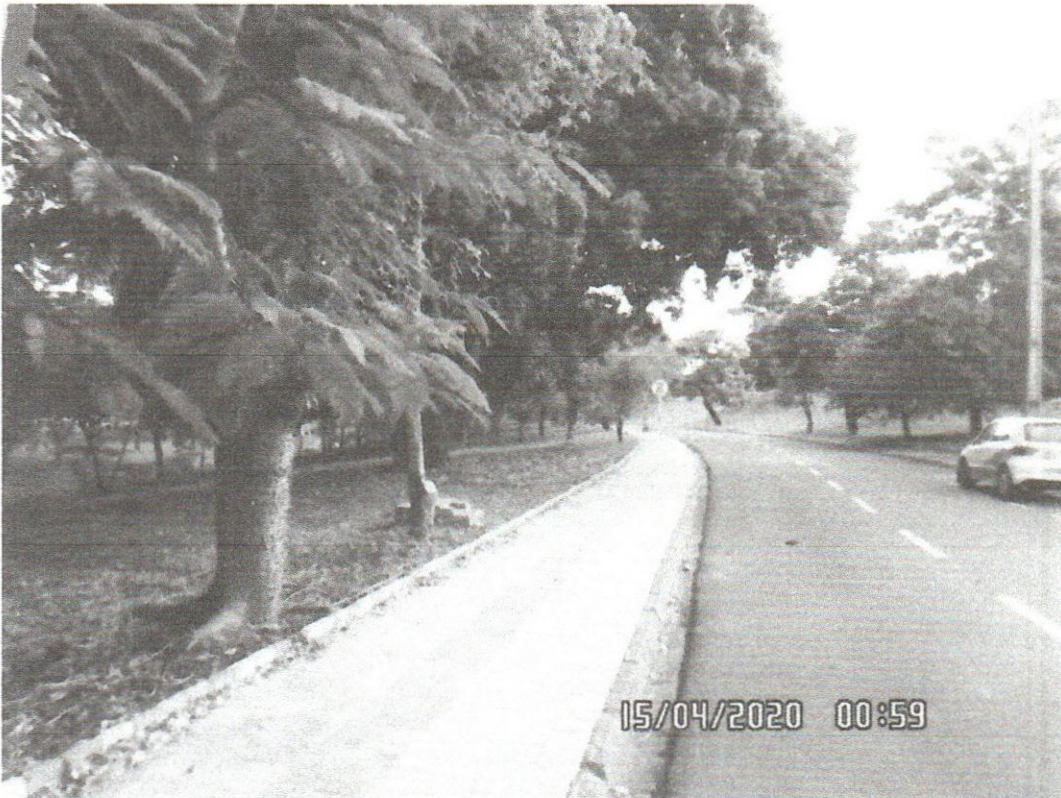
Execução de Pavimentação em lajota de concreto no canteiro central da Avenida Mangara entre a Rua Pedro Curti e Rua Filomena Tofaneli Bomfim
