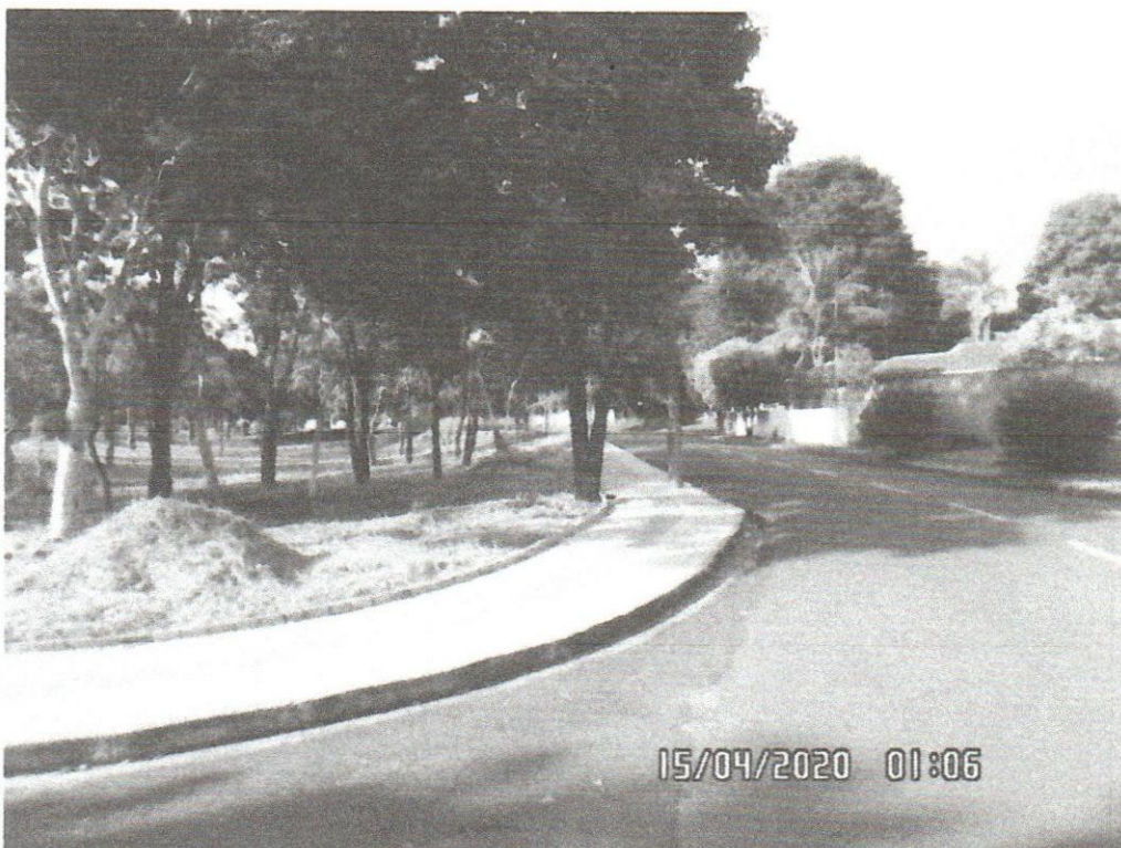
Execução de Pavimentação em lajota de concreto no canteiro central da Avenida Mangara entre a Rua José Olico e Rua Pedro Curti
