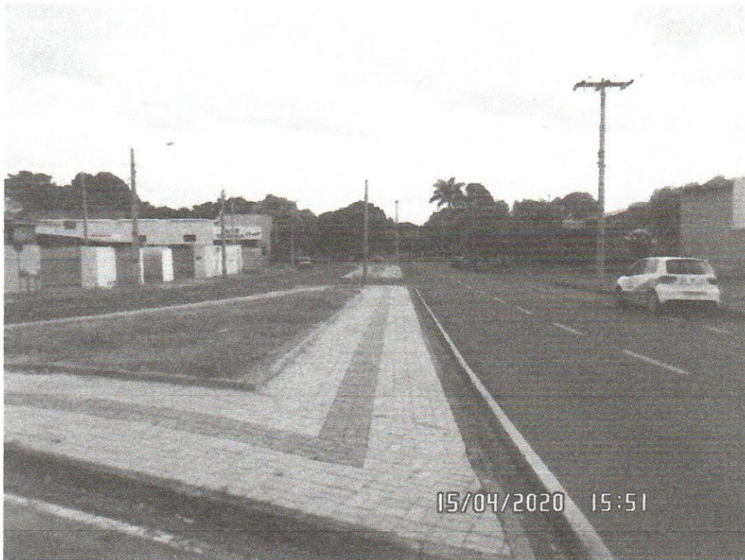
Execução de Pavimentação em lajota de concreto no canteiro central da Avenida Mangara entre a Rua das Margaridas e Rua Julio Quinaglia
