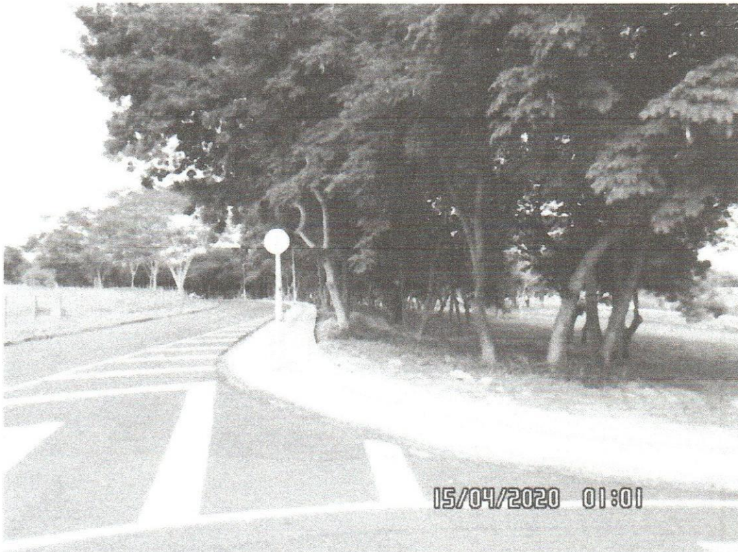
Execução de Pavimentação em lajota de concreto no canteiro central da Avenida Mangara esquina com Rua Filomena Tofaneli Bomfim
