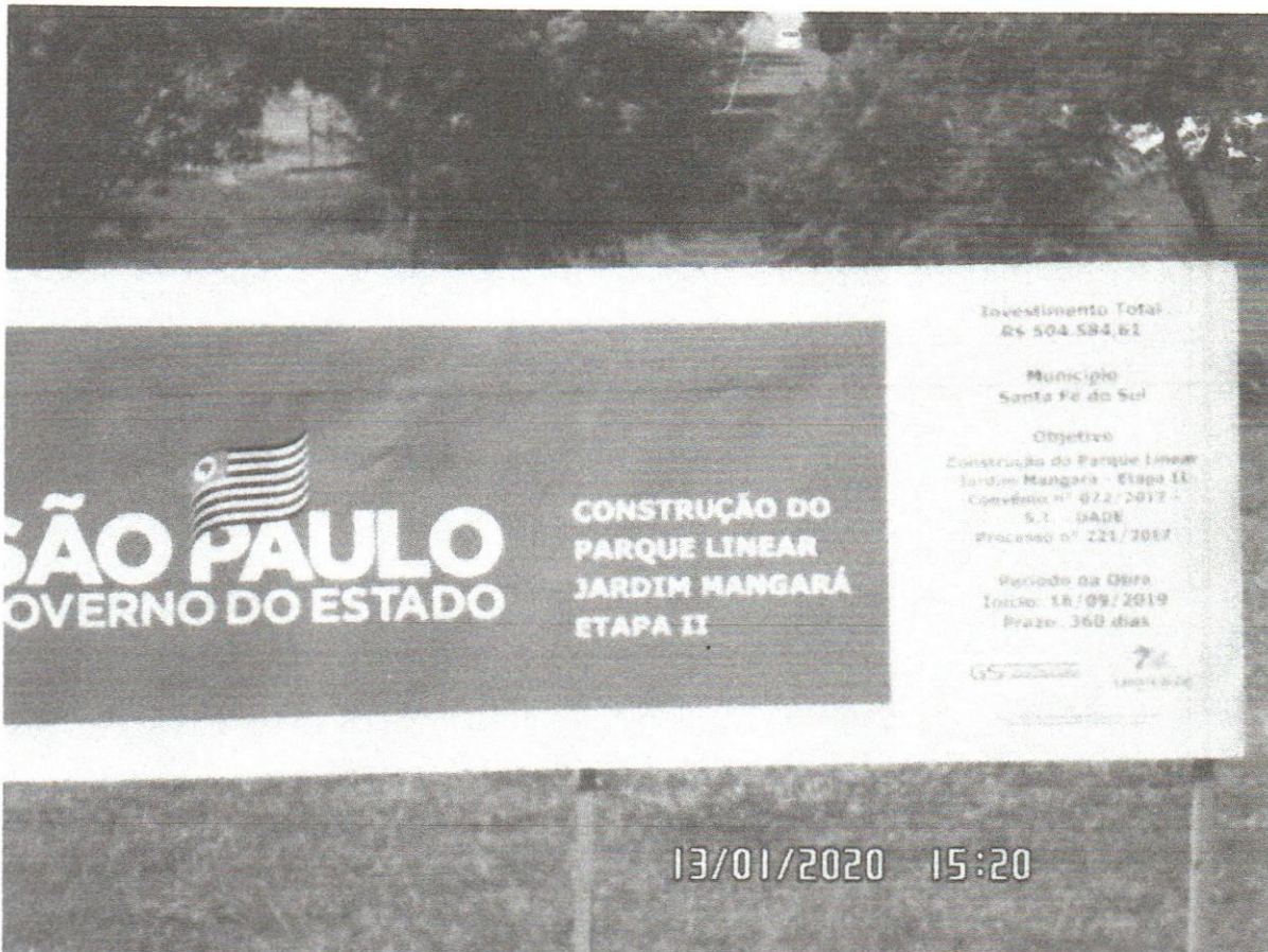
Placa da obra implantada na Avenida Mangara
