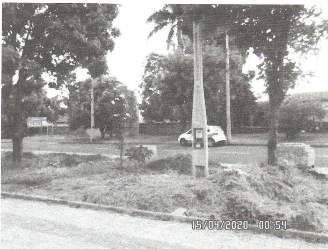
Implantação de Poste, proximo a esquina da Rua José Olico
