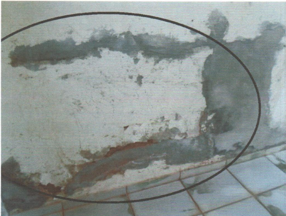
Foto 05: parede da divisa paralela com ferrovia.
