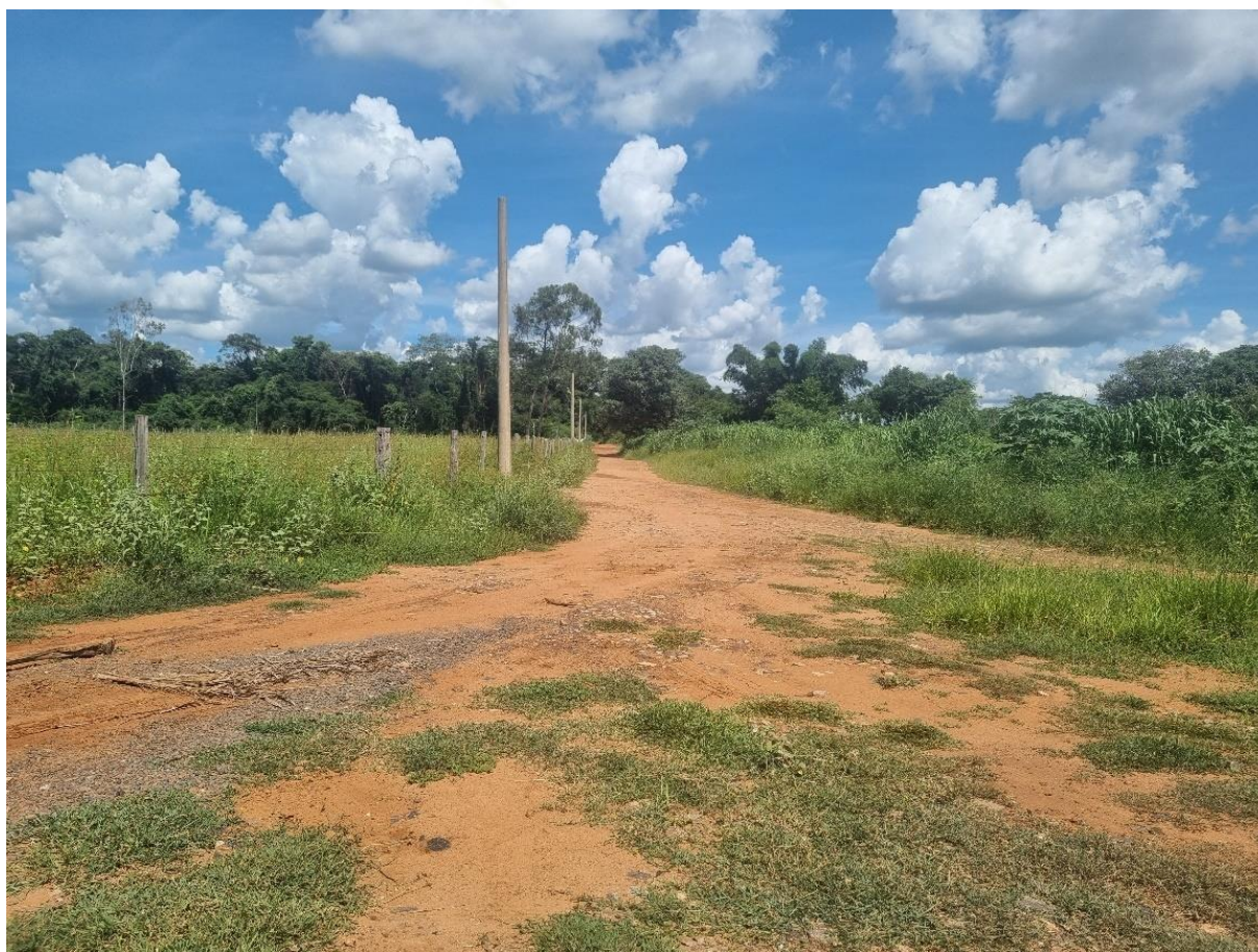
Figura 47 – Estrada com trechos sem saída d'água.
