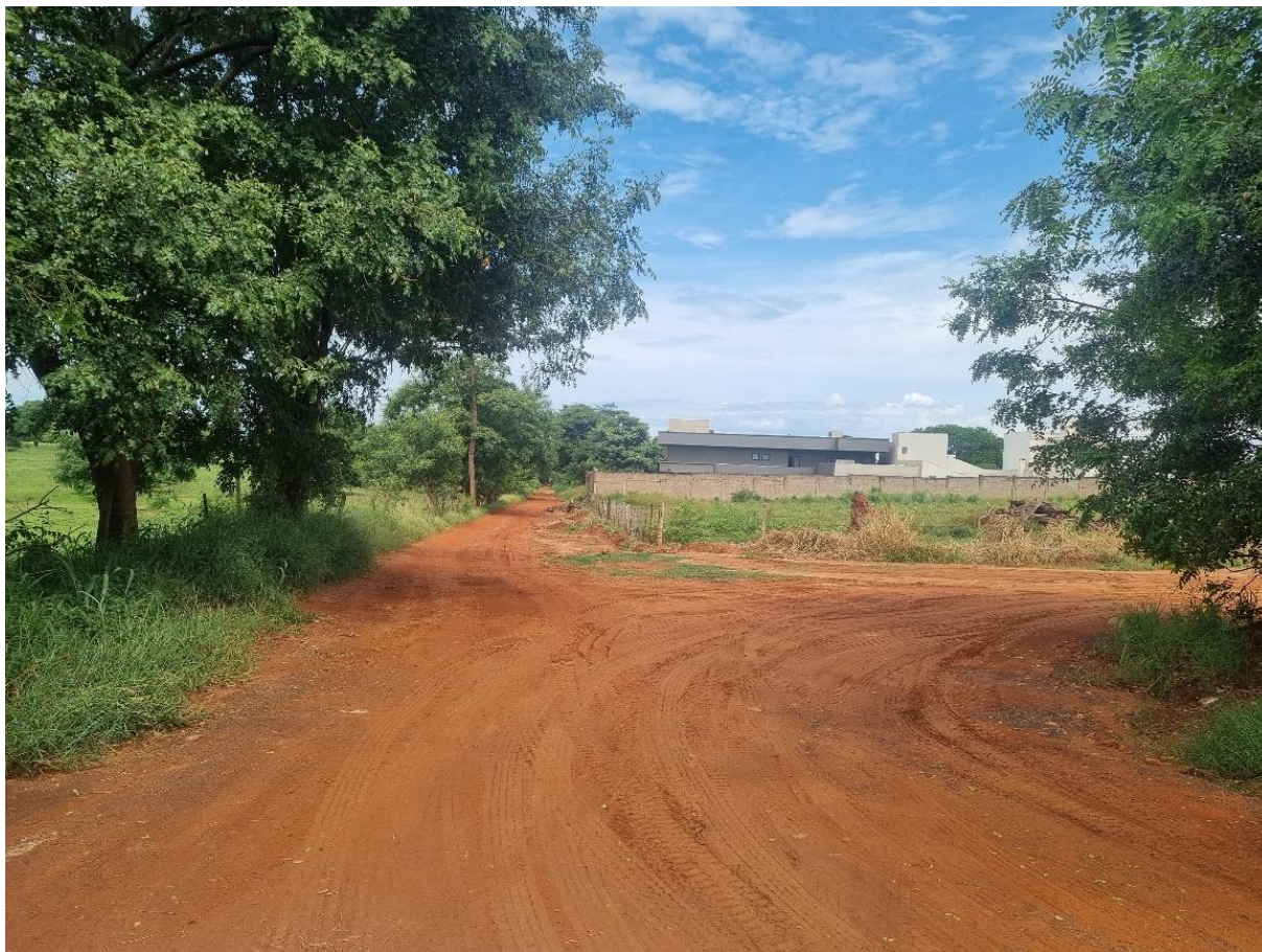
Figura 38 – Estrada sem revestimentos e com trechos sem saída d'água.
