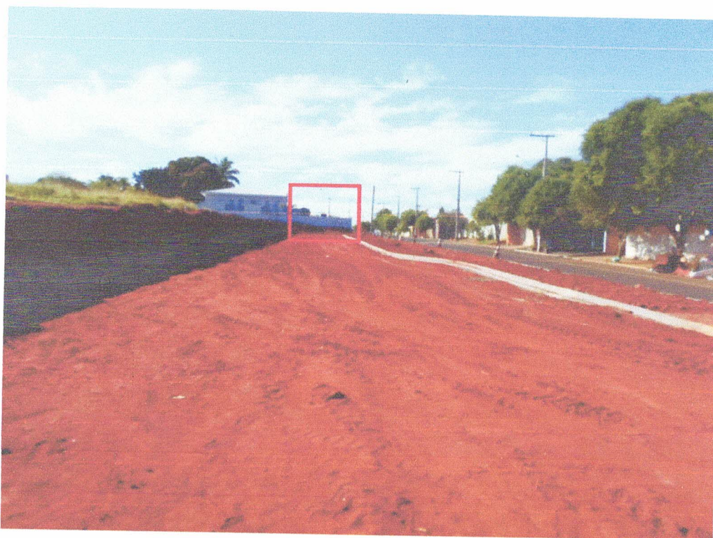
Foto de 2020, destacado a área a ser desapropriada para abertura de avenida
